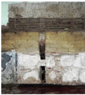
Técnicas Constructivas Tradicionales. Muro de construcción Mixta. Bahareque, adobe, sillares. Fotografía Ana Oropeza
