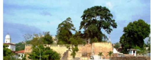
Vista actual de la fortificación desde la ventana de una vivienda en la calle Sucre. Obsérvese los grandes árboles dentro y en la periferia de la edificación, que amenazan la solidez de la estructura. Fotografía Ana Teresa Oropeza.
